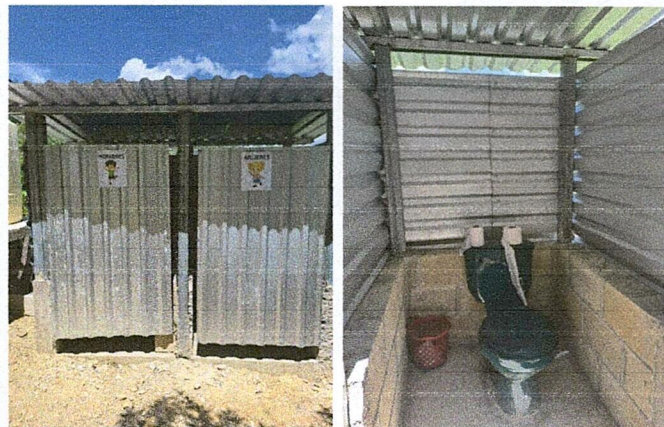
Fotos 2: Mejoramiento de área de servicio de sanitario
